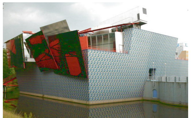
Coop Himmelb(l)au / Anbau als dreidimensionales Kunstwerk
