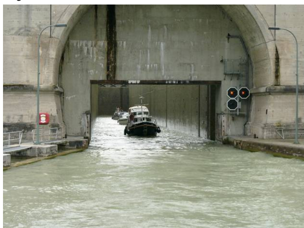
Schleuse Anderten bei Hannover
