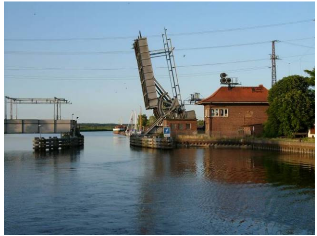
Historische Eisenbahnklappbrücke in Anklam
