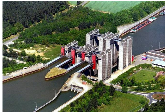
Schiffshebewerk Scharnebeck bei Lüneburg
