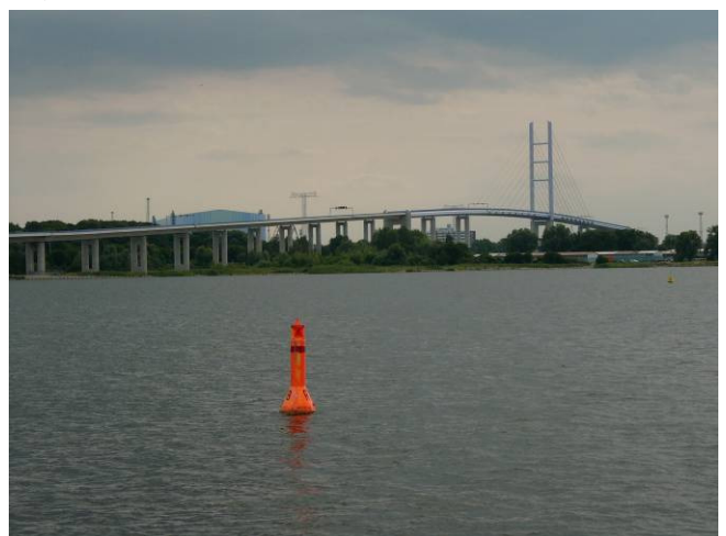
Die neue Rügenbrücke
