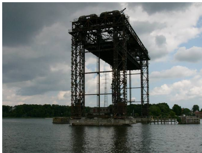
Eisenbahnbrückentorso bei Karnin
