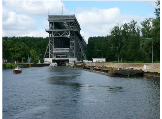
Das Schiffshebewerk Niederfinow mit einem Hub von 36 m vom Unterwasser aus gesehen
