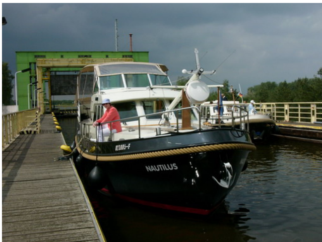
Im Oberwasser des Schiffshebewerks Magdeburg-Rothensee
