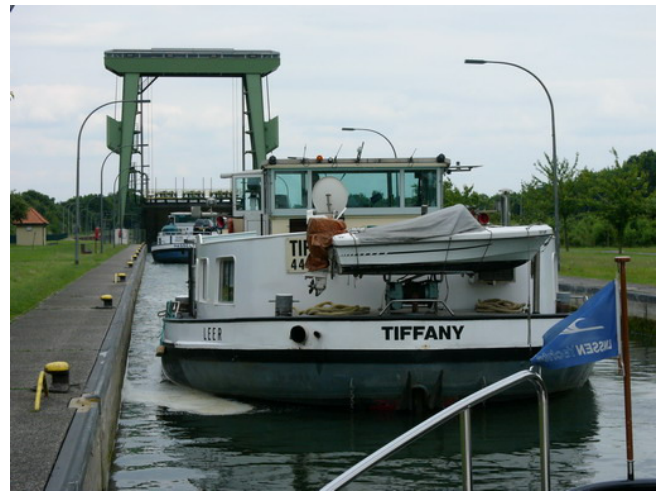
Schleuse im Zuge des Wesel-Datteln-Kanals
